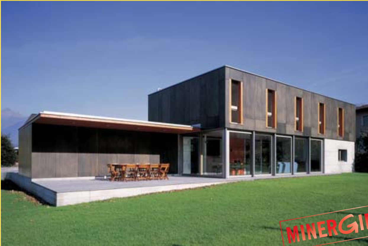
Oggetto: Casa privata Luogo: Camorino Anno di costruzione: 2002 Rivestimento: Multistrato di Okumé impregnato nero Architetto: Studio d'architettura Biagio Lepori, 6500 Bellinzona Ingegnere: Enrico Bischof, ing. civile STS, 6862 Rancate Fotografo: Lorenzo Mussi, Lissone (MI)
