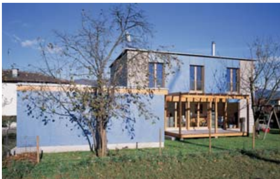
Oggetto: Casa Lorenzon Luogo: Ligornetto Anno di costruzione: 2002 Rivestimento: Abete preinvecchiato, pannelli di abete e pannelli di OSB verniciati Progettista: Gianfranco Croci, studio tecnico e consulenze edili, 6862 Rancate Ingegnere: Enrico Bischof, ing. civile STS, 6862 Rancate Fotografo: Lorenzo Mussi, Lissone (MI)
