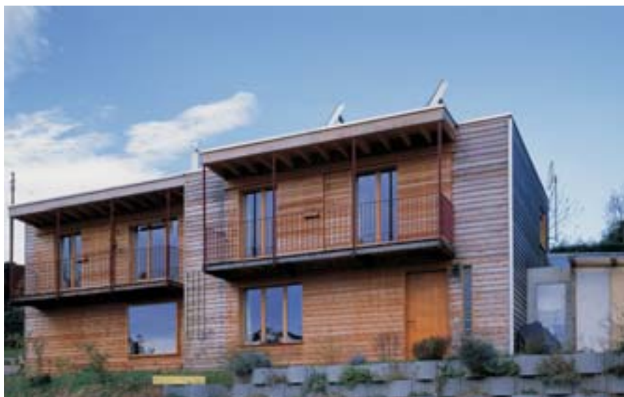
Oggetto: Casa privata Luogo: Carona Anno di costruzione: 2000 Rivestimento: Larice naturale Progettista: Gianfranco Croci, studio tecnico e consulenze edili, 6862 Rancate Ingegnere: Enrico Bischof, ing. civile STS, 6862 Rancate Fotografo: Lorenzo Mussi, Lissone (MI)
