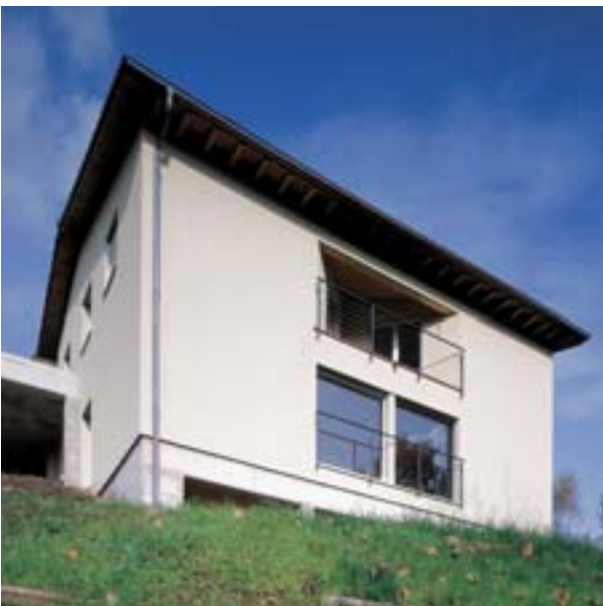
Oggetto: Casa Bernasconi Luogo: Astano Anno di costruzione: 2002 Rivestimento: Pericon-Board® Architetto: Roberto Rezzonico, 6964 Davesco-Soragno Ingegnere: Enrico Bischof, ing. civile STS, 6862 Rancate Fotografo: Lorenzo Mussi, Lissone (MI)
