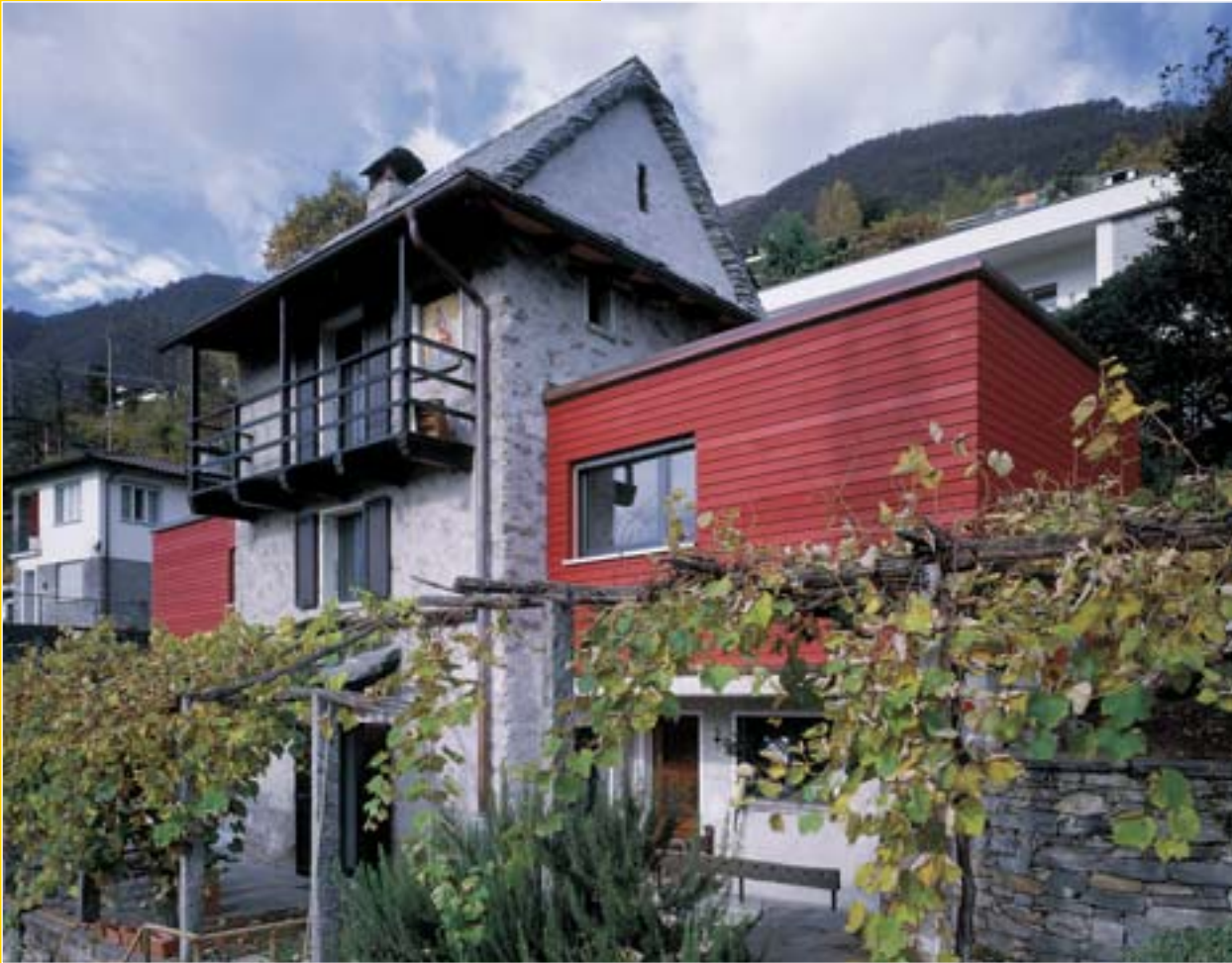
Oggetto: Casa privata Luogo: Minusio Anno di costruzione: 2002 Rivestimento: Douglas verniciato Fotografo: Lorenzo Mussi, Lissone (MI)
