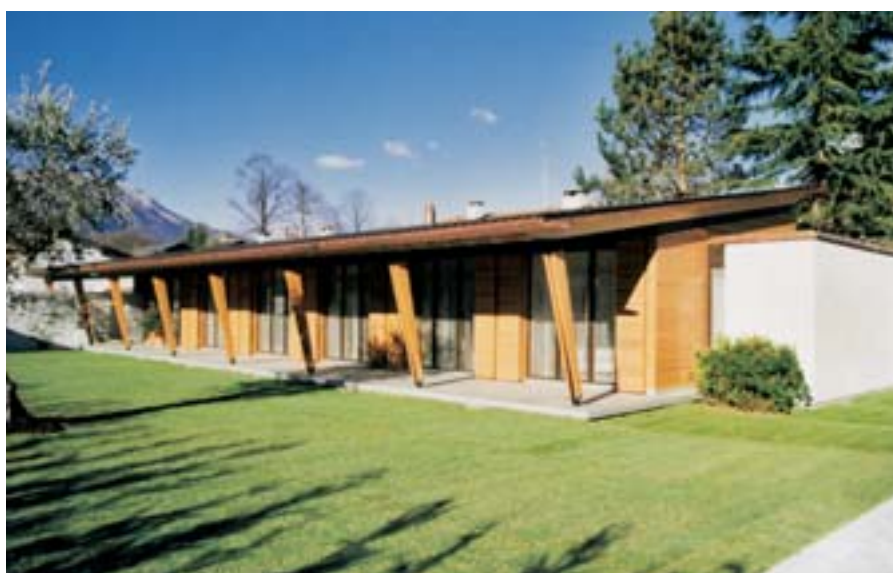
Oggetto: Casa privata Luogo: Cureglia Anno di costruzione: 2001 Rivestimento: Cedro tintato rosso Architetto: Studio d'architettura Sergio Grignoli, 6944 Cureglia Ingegnere: Enrico Bischof, ing. civile STS, 6862 Rancate Fotografo: Piernicola Federici, 6541 Santa Maria
