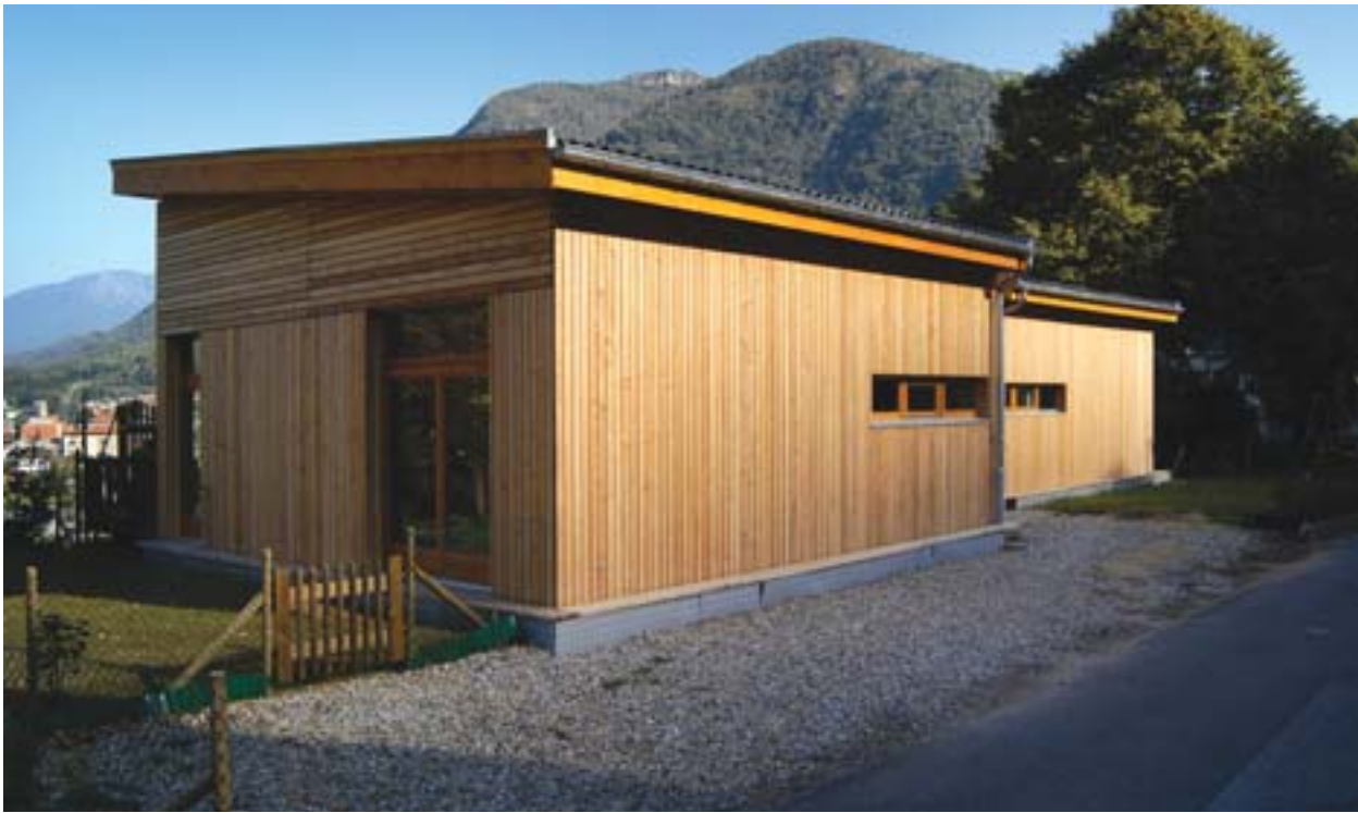
Oggetto: Casa privata Luogo: Camignolo Anno di costruzione: 2002 Rivestimento: Larice naturale Architetto: Roberto Caronna, 6950 Bellinzona Fotografo: Milo Keller, 6900 Massagno
