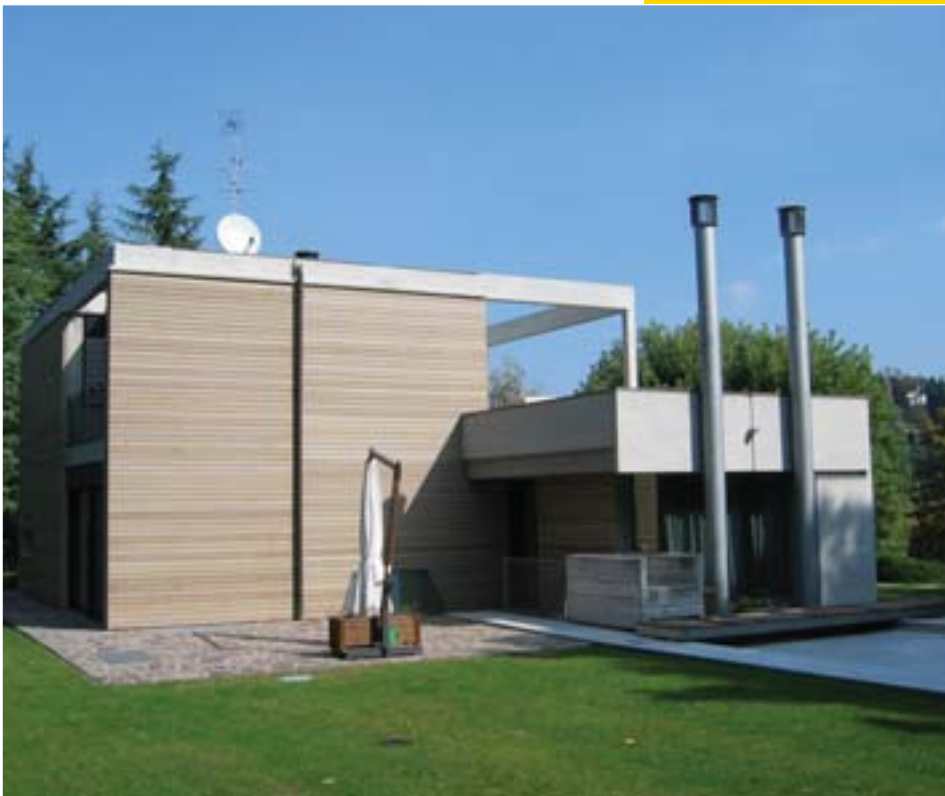
Oggetto: Casa Mazzola Luogo: Sirtori (LC) Italia Anno di costruzione: 2003 Rivestimento: Cedro preinvecchitato Architetto: Luca Mazzola, Calco (Lecco) Fotografo: GEK, Lugano
