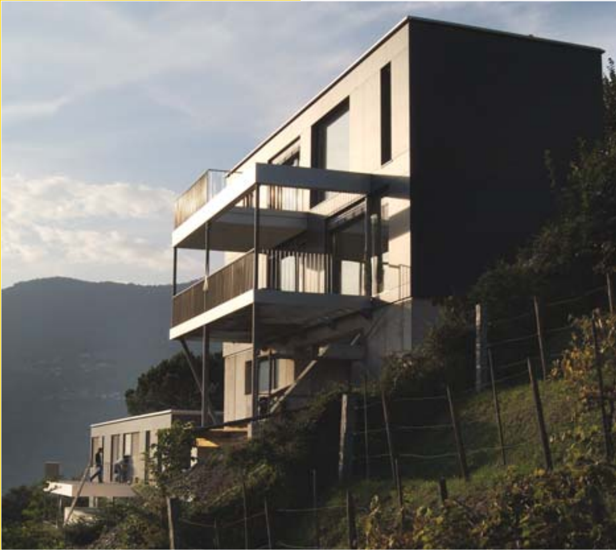
Oggetto: Casa privata Luogo: Muzzano Anno di costruzione: 2004 Rivestimento: Eternit Architetto: Leonardo Modena, 6500 Bellinzona Ingegnere: Enrico Bischof, ing. civile STS, 6862 Rancate Fotografo: Milo Keller, 6900 Massagno
